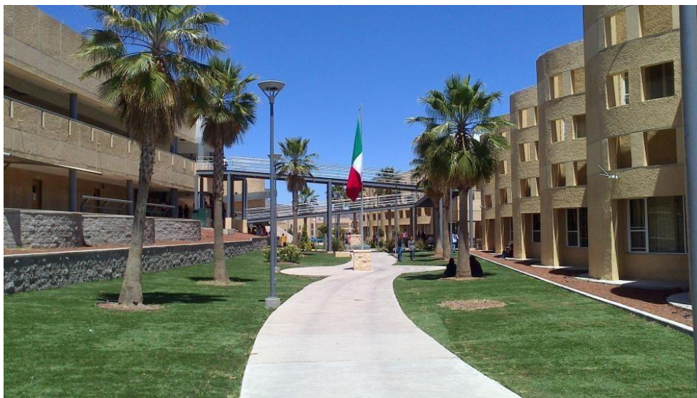
Figura 4. Pasillo entre salones de la Facultad de Ciencias Químicas
